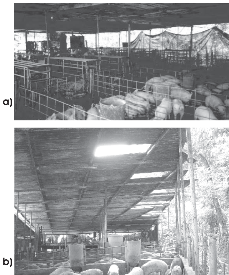
Figura 7.30. Estado de los techos: a) antes de P+L; b) después de P+L.
